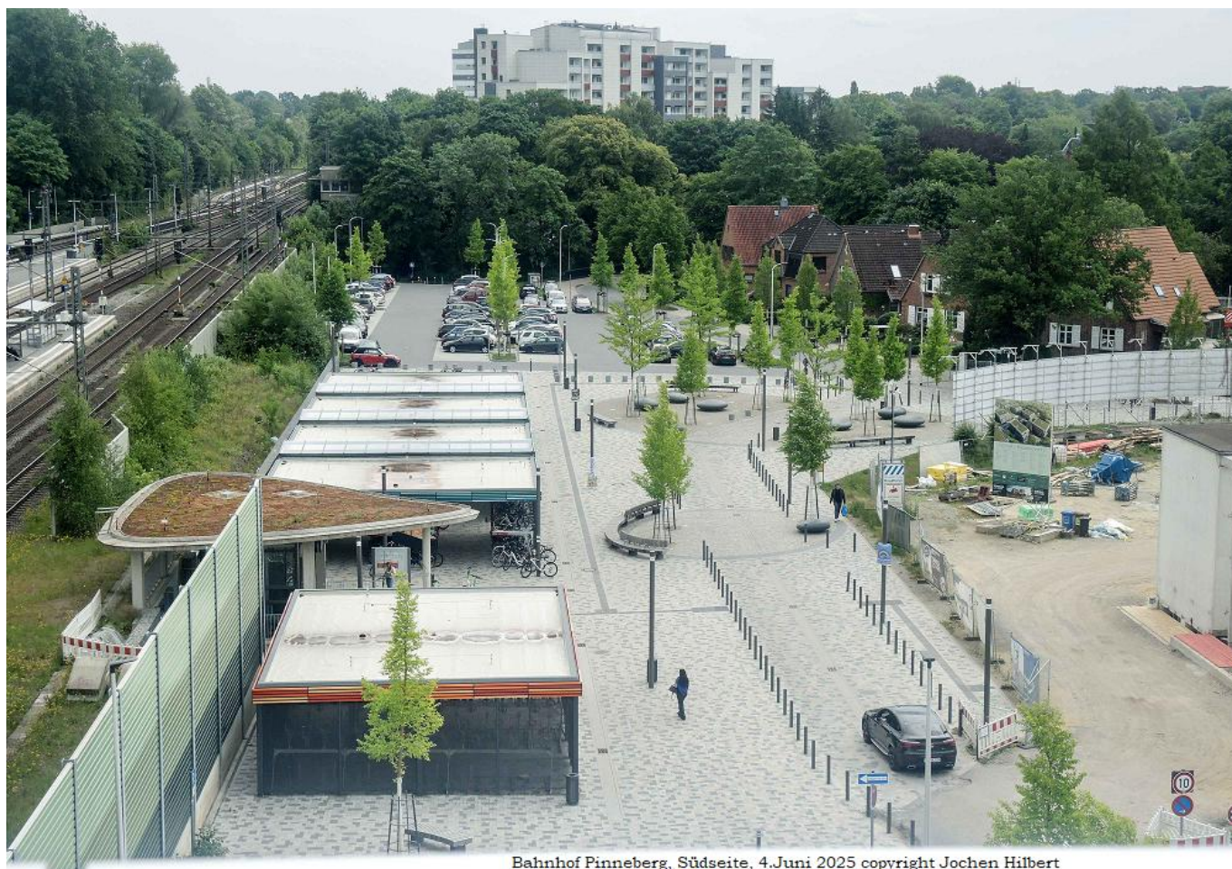
Bahnhof Pinneberg, Südseite, 4.Juni 2025 copyright Jochen Hilbert
