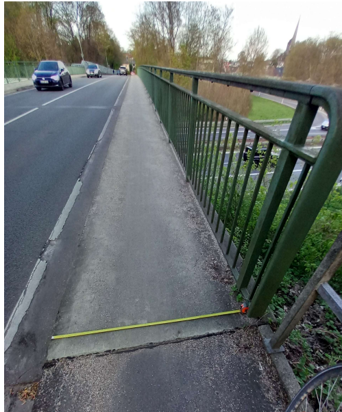
Abbildung 1: Dieser gemeinsame Geh- und Radweg hat eine lichte Breite von nur 1,40m. Für die Ausschilderung eines gemeinsamen Fuß- und Radweges mit VZ 240 muss ein bestehender Weg innerorts eine Mindestbreite von 2,50 m – außerorts 2,00 m – vorweisen.
