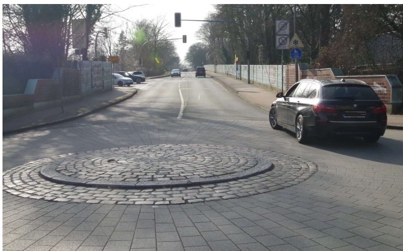
Abbildung 4: Kreisverkehr Ehmschen/ Rellinger Straße / Am Markt. Dieser Kreisverkehr soll die Autofahrer, die von der Autobahn kommen ausbremsen und auf die Tempo 20 Zone in Am Markt vorbereiten.
