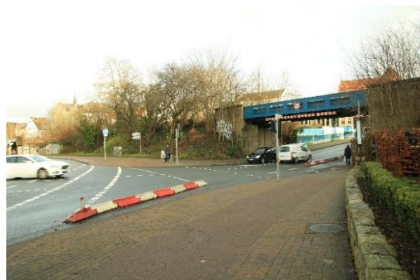
Abbildung 26: EÜ Heinrichstraße (Blickrichtung Nord-Osten, eigene Abbildung)
