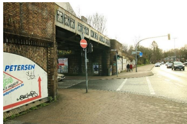
Abbildung 20: EÜ Angelburger Straße . (Blickrichtung Süden, eigene Abbildung)
