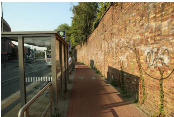
Abbildung 19: Stützbauwerk an Straße Süderhofenden . (Blickrichtung Norden, eigene Abbildung)
