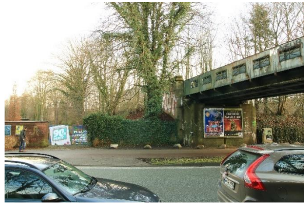
Abbildung 24: EÜ Bahnhofstraße (Blickrichtung Norden, eigene Abbildung)
